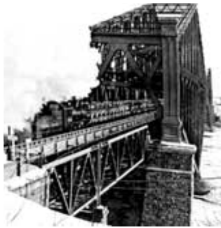
Les travaux du pont de Québec ont débuté en 1903. Il mesure 26,5 m de large et comporte deux voies ferrées, deux voies de tramway et deux voies routières. Il fut inauguré le 22 août 1919
